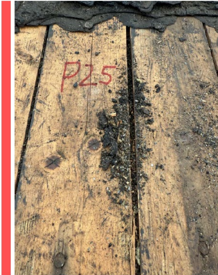
Figur 14 Prøvetaking av støvrester/partikler mellom rupanel.
