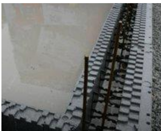
Figur 5: Ringmurselementer av EPS og hardplast (foto: www.vartdalplast.no ).
