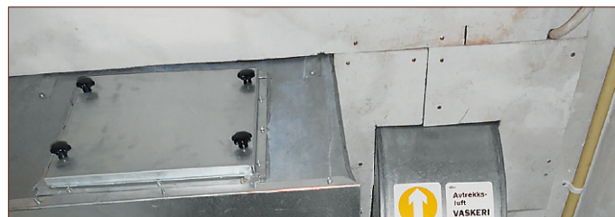
Płyty azbestoluxu na suficie w wentylatorni. Płyty azbestowe często są w kolorze biało-szarym. Płyty azbestowe nie mają pokrycia papierowego. (Płyta gipsowo-kartonowa ma pokrycie papierowe i zwykle nie zawiera azbestu).
