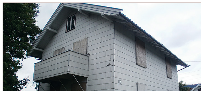
Płyty eternitowe na elewacji.
