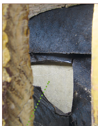
Płyta wiatroizolacyjna (cienka, twarda żółta płyta) w ścianie zewnętrznej za papą (czarnym kartonem). Może występować zarówno za okładziną drewnianą, jak i za okładziną z blachy.
