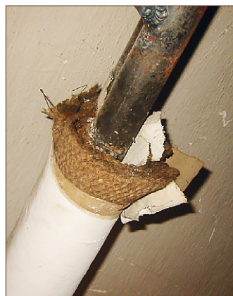
Hvit asbestpapp innerst på røret (under brun jutevev). Mest vanlig i perioden fra 1900 til 1960.
