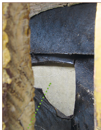
Vindsperreplate (tynn hard gul plate) i yttervegg bak svartpapp. Finnes både bak trekledning og bak metallplatekledning.
