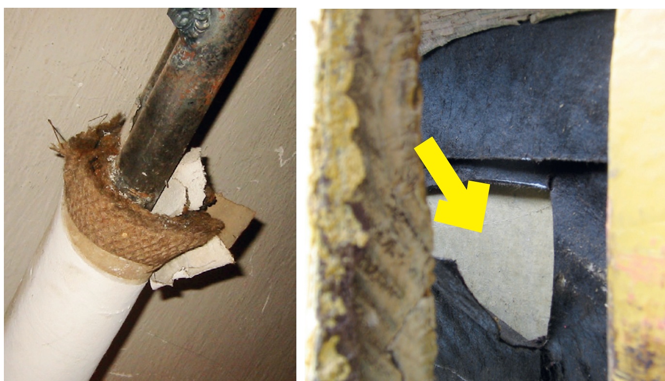
Hvit asbestpapp innerst på røret (under brun jutevev). Mest vanlig i perioden fra 1900 til 1960.
