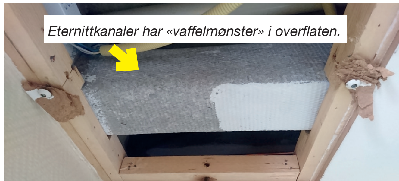
Firkantet ventilasjonskanal av grå eternitt med asbest.
