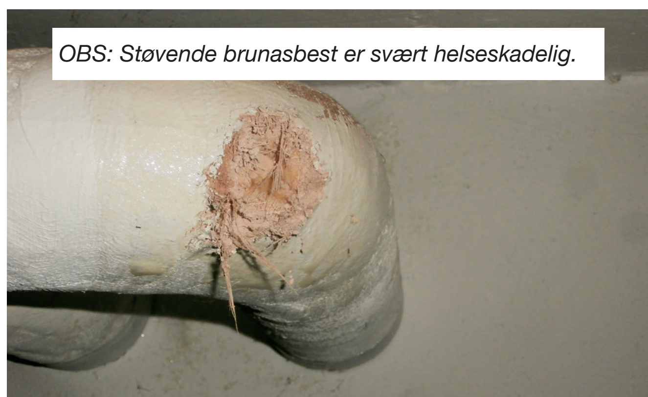
Asbestmasse i rørisolasjon på rørhjørne. Mest vanlig i perioden 1955 – 1978.
