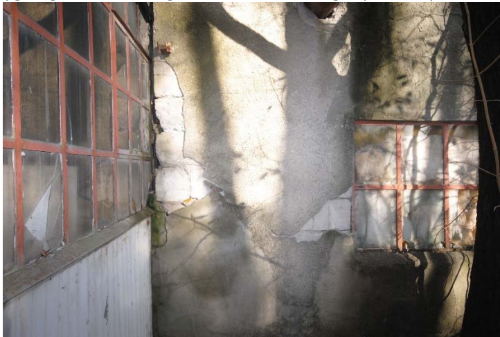
Figur 12 Ytong/Siporex uten radioaktivt tilslag er gråhvit (foto: Eirik Wærner).
