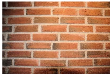
Figur 9 Moderne maskinprodusert teglstein med sementmørtel.
