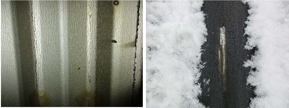
Figur 21 Eksempel på Robertson-plater med krakelert overflate (begge foto: Kristian M. Ulla).
