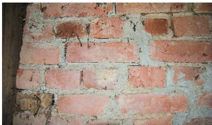
Figur 8 Gammel teglstein murt med kalkmørtel.
