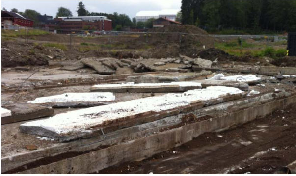
Figur 26 Isopor brukt til isolering av gulv på grunn (foto: Norsk Saneringsservice).
