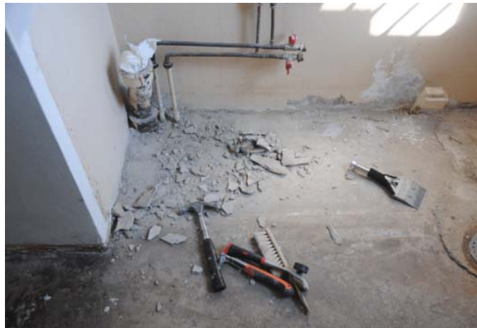
Figur 16 Prøvetaking av avrettingslag (foto: Eirik Wærner).
