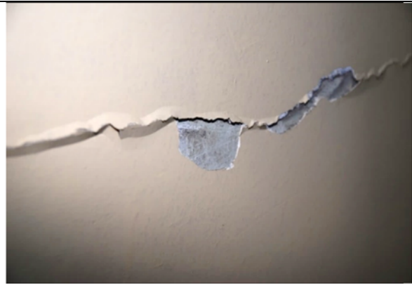
Figur 5 Prøve av samme vegg, hvor malinglaget løsnet uten puss. Resultat: Farlig avfall (foto: Eirik Wærner).
