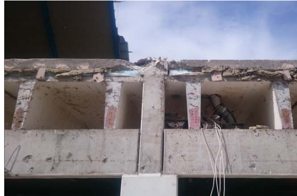
Figur 29 Styrofoam (blå) brukt til isolering av dekke (Foto: Norsk Saneringsservice).
