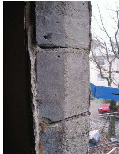
Figur 13 Blåbetong, Ytong med radioaktivt tilslag (foto: Eirik Wærner).
