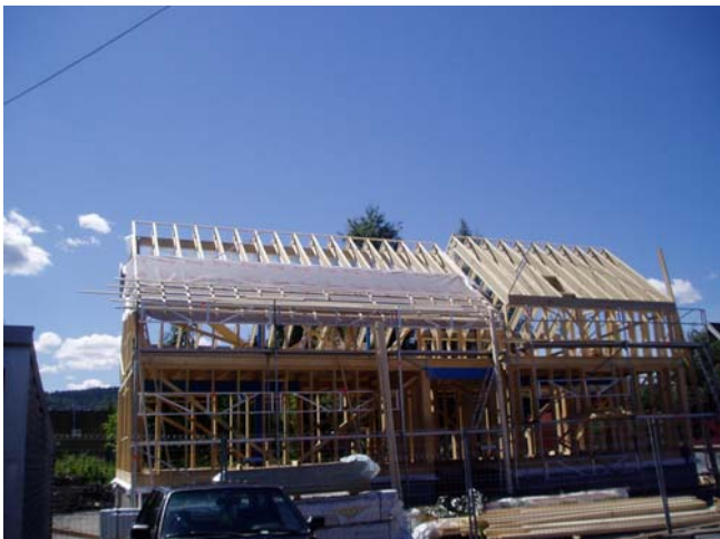
Figur 4: Lavenergibolig på Lillestrøm (kilde: Byggforsk).
