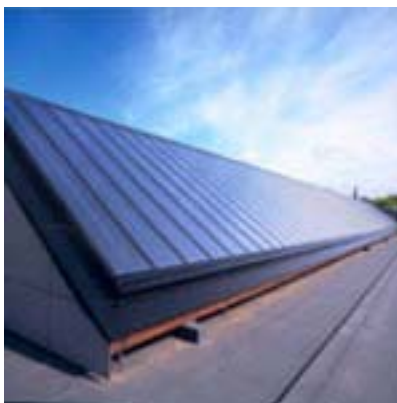
Figur 3: Solfanger på taket av Klosterenga økologiboliger (kilde: http://www.klosterenga.net ).
