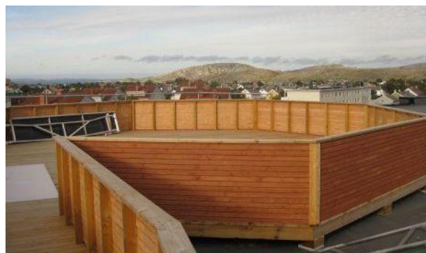
Bilde 3: Takterassen (GJ)
